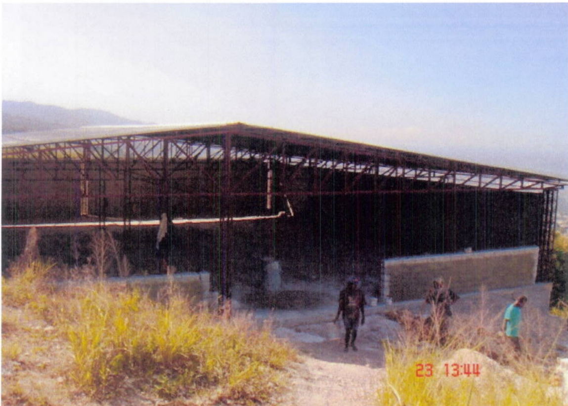
Hangar 2 en Construction
