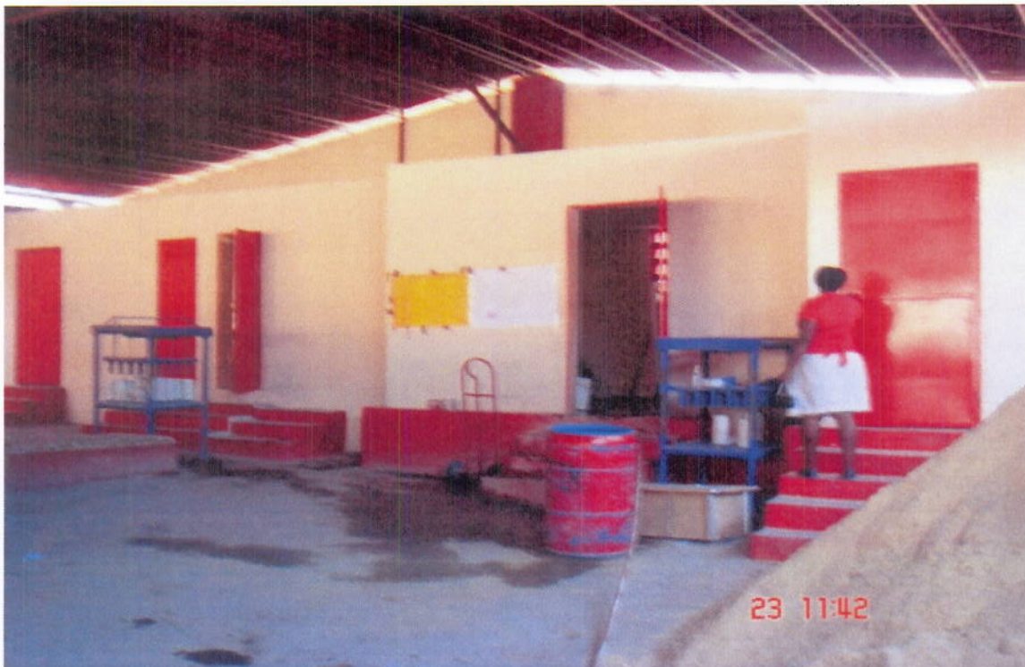
Bâtiment ayant un bloc sanitaire, un réservoir pour stocker l'eau et un dépôt
