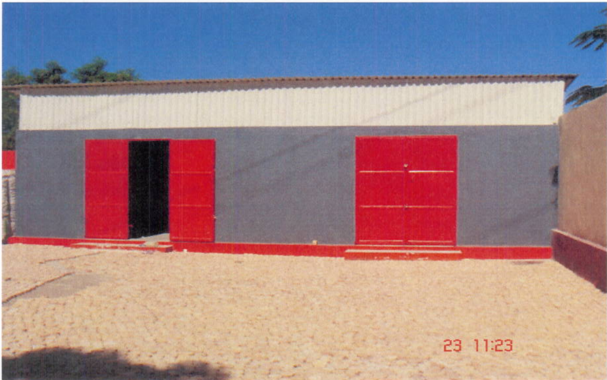
Bâtiment de stockage des briquettes et des outils
